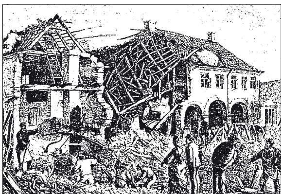
Ikke alt fungerede efter hensigten - resultatet af en kedeleksplosion på hørspinderiet i Hillerød i 1873.
